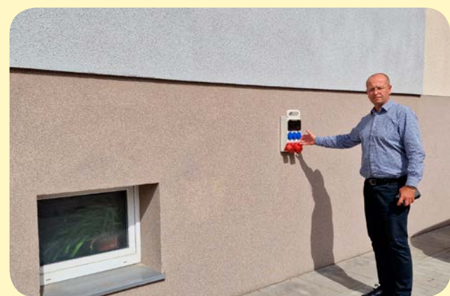
W Cedrach Wielkich jest już wszystko gotowe na przyjęcie zespołu ratownictwa medycznego. Piotr Jaśniewski, z-ca wójta gminy Cedry Wielkie, przy przyłączeniu elektrycznym do karetek
