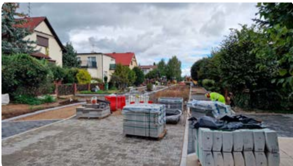
➤ Prace drogowe prowadzone są także na ulicy Reymonta
