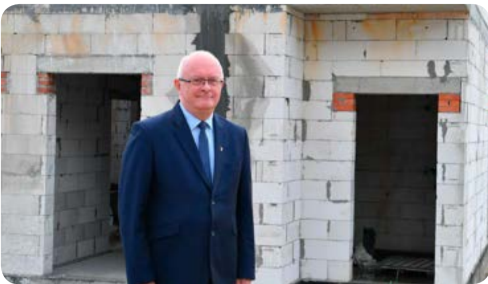
Starosta gdański Marian Cichon na budowie placówki opiekuńczo-wychowawczej
