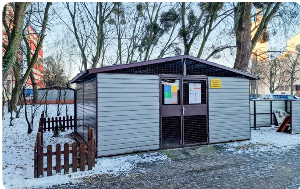
➤ Na terenie „trójki” wybudowano w tym roku m.in. nowe altany śmietnikowe
