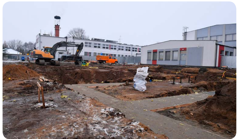
➤ Ruszyła rozbudowa szkoły w Kłodawie
