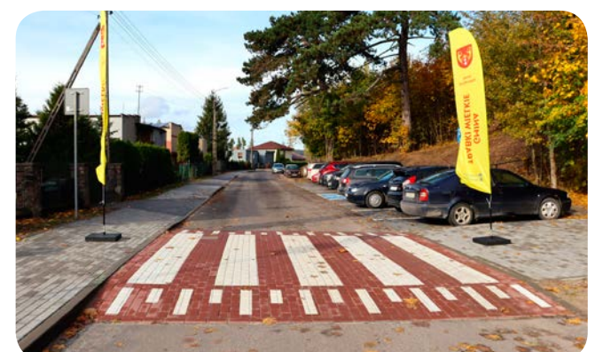
➤ W tym roku przebudowano ul. Sportową w Sobowidzu
