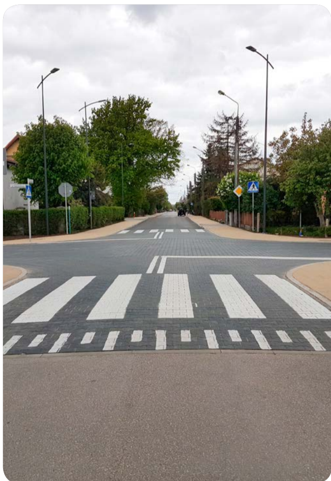
Przebudowa ulicy Słowackiego w Pruszczu Gdańskim – 10,4 mln zł
