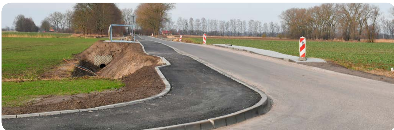
Przebudowa drogi Błotnik – Trzciniśko – 14 mln zł
