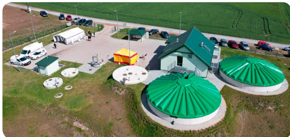
↗ Oczyszczalnia ścieków w Sobowidzu (wartość projektu 24 600 000 zł - dofinansowanie 16 100 000 zł)
