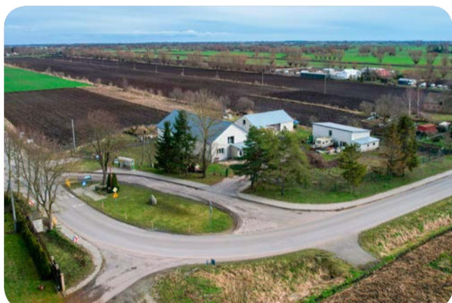
Przebudowa drogi Ostrowite – Suchy Dąb wraz z przebudową mostu i budową chodnika w Ostrowitem – 12,8 mln zł
