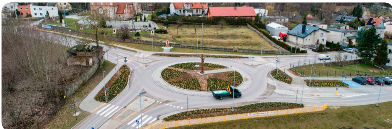
Budowa ronda w Pręgowie i chodnika Kolbudy – Pręgowo – 4,5 mln zł
