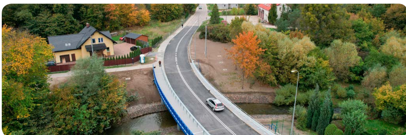
Budowa mostu wraz z remontem ul. Przemysłowej w Kolbudach – 4,6 mln zł
