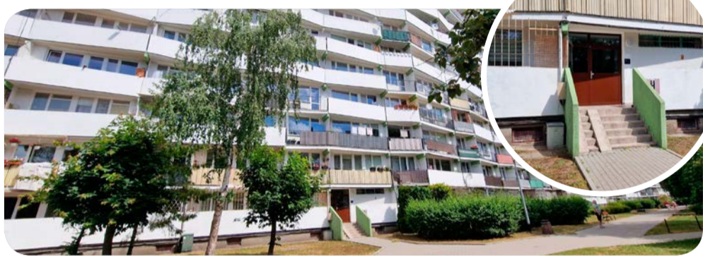
➤ Jeszcze w tym roku udrożnione będą dwa przejścia z falowca na stronę balkonową budynku. Mowa o klatkach I oraz F
