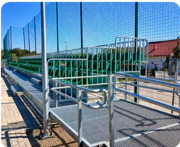
Podest dla osób z niepełnosprawnościami przy boisku w Rotmance.
