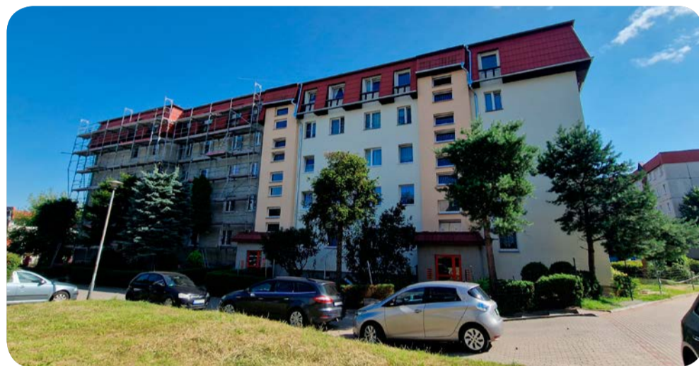
⚠ Działania spółdzielni oparte są na 5-letnim planie, który obowiązuje tylko do 2026 roku, a w jego ramach prowadzony jest remont elewacji w budynku przy ul. Emilii Hoene 5
