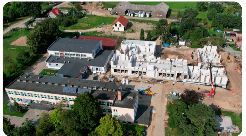
W Kłodawie trwa rozbudowa Szkoły Podstawowej
