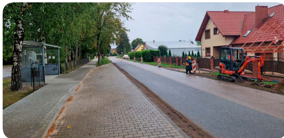
☞ Przebudowa drogi Krzywe Koło - Koźliny
