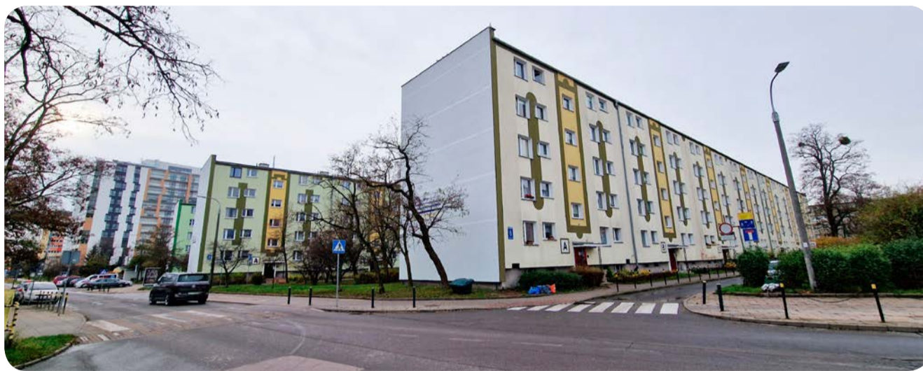
📍 Elewacje naprawiono już w pierwszych budynkach przy ulicy Kaczyńskiego 6, 8 i 10.
