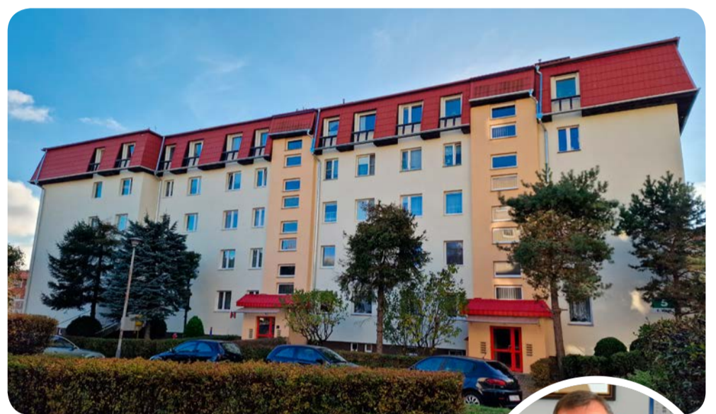
Wyremontowano elewację budynku przy ul. Emilii Hoene 5
