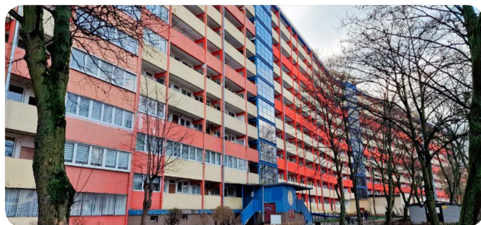
↗ Remontowany i malowany jest faldowiec przy Jagiellońskiej 10
