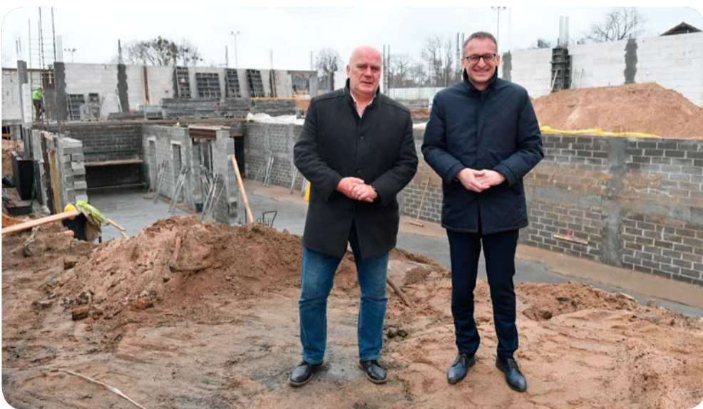
🚧 Janusz Wróbel, burmistrz Pruszcza Gdańskiego i Piotr Kaliński, dyrektor Szkoły Podstawowej nr 3, przy której budowana jest sala sportowa
