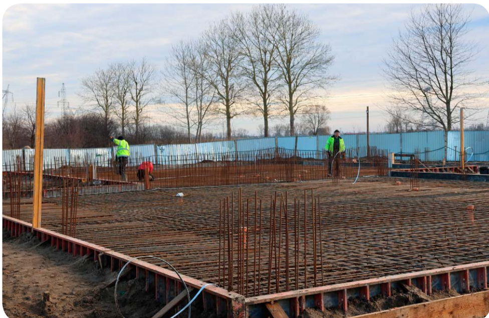
W Przejezdowie ruszyła budowa obiektu, który będzie pełnił dwie funkcje: świetlicy wiejskiej oraz remizy OSP. Powstanie tu również plac zabaw i strefa street workout. Cały teren zostanie oświetlony.
