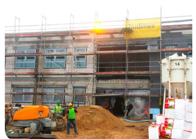
Trwa budowa szkoły w Jagatowie
