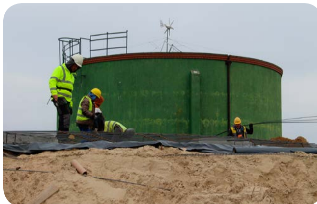
Rok 2021. Budowa zbiornika do gromadzenia wody uzdatnionej w Arciszewie
