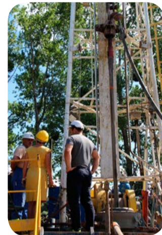
Rok 2019. Odwiert dwóch studni głębinowych w Rekcinie
