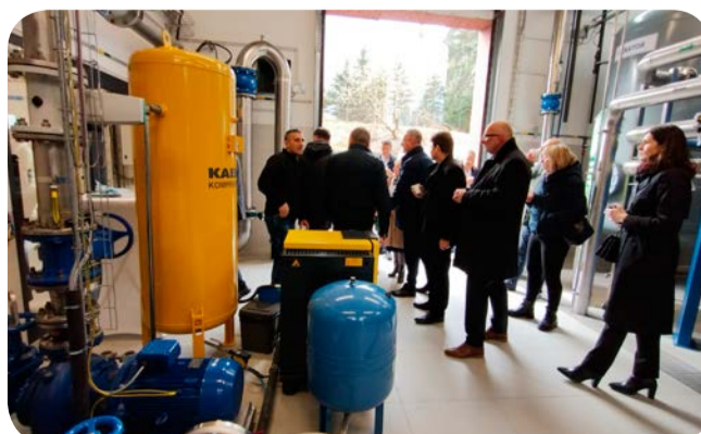
Rok 2024. Otwarcie rozbudowanej stacji uzdatniania wody w Rotmance
