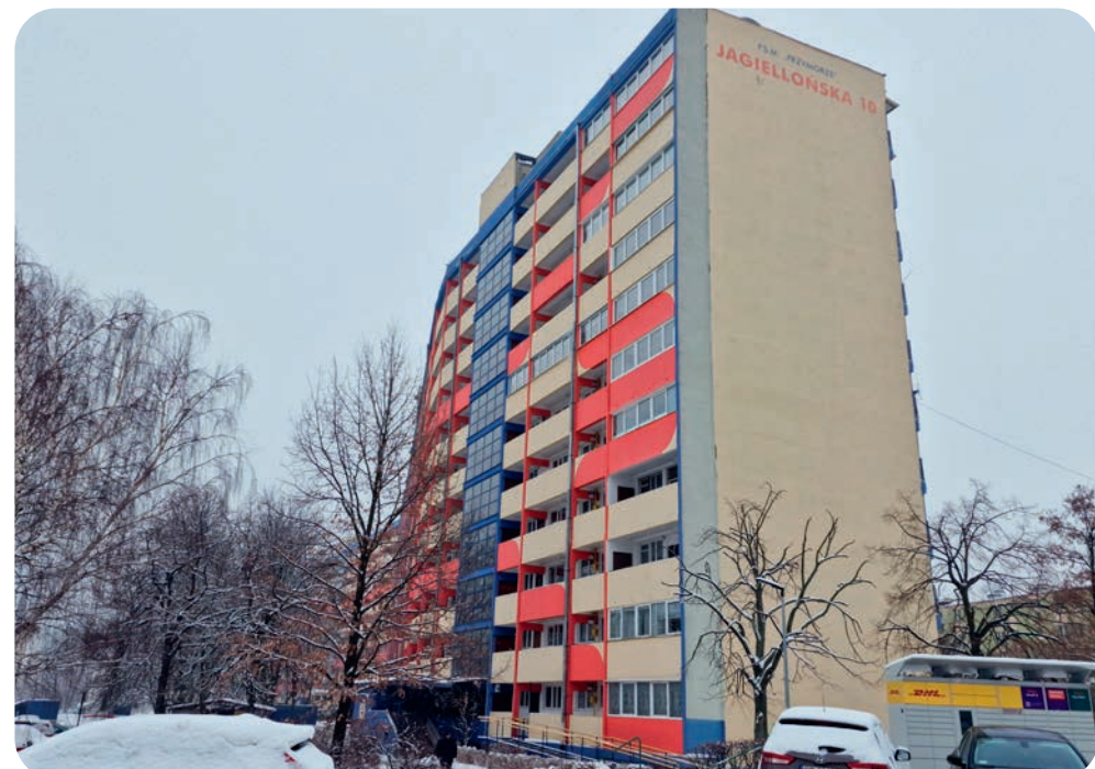
➤ Na ten rok zaplanowano także kontynuację napraw i malowanie galerii budynku przy Jagiellońskiej 10
