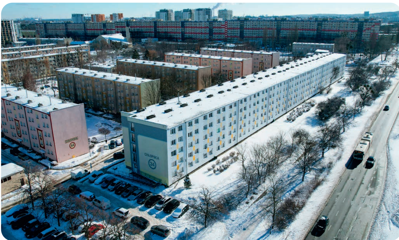
➤ Na ten rok zaplanowano remont poszycia dachowego przy Chłopskiej 34
