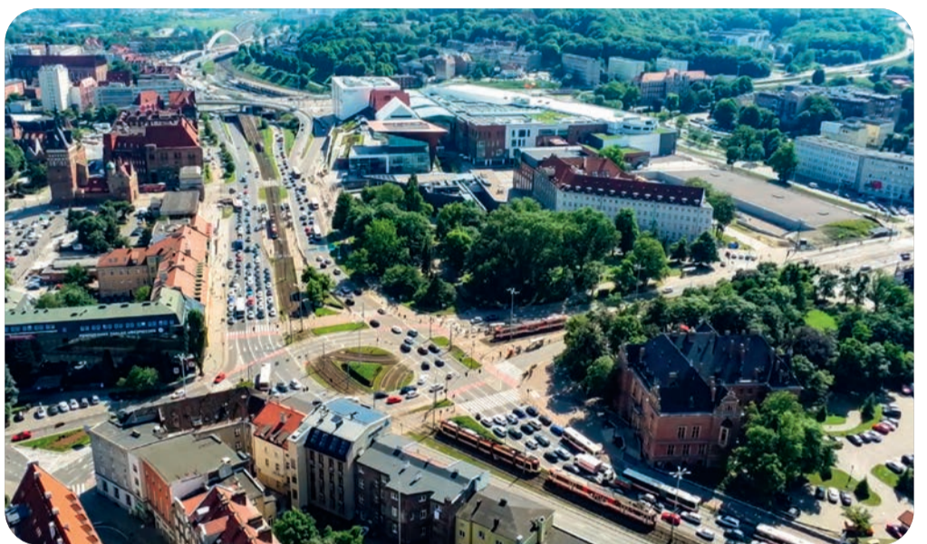
➤ Modernizacja Węzła Hucisko to jedno z najbardziej wymagających działań infrastrukturalnych realizowanych w ostatnich latach w Gdańsku
