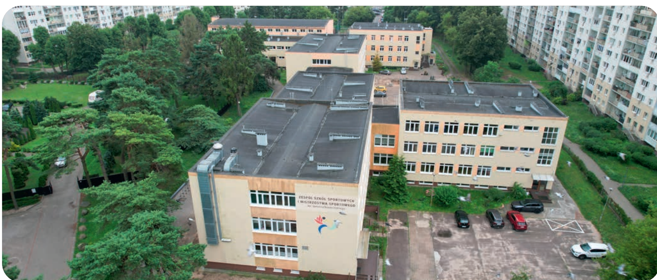
W Zespole Szkół Sportowych i Mistrzostwa Sportowego przy ul. Subisława, jest modernizowany basen i sala gimnastyczna
