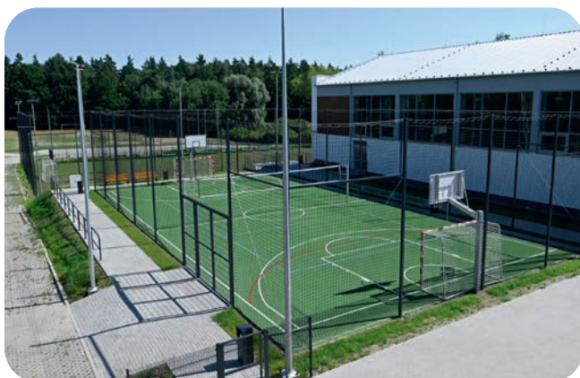
W ramach inwestycji powstało również boisko wielofunkcyjne
