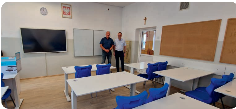
W Szkole Podstawowej nr 3 wymieniono podłogi w trzech salach lekcyjnych
