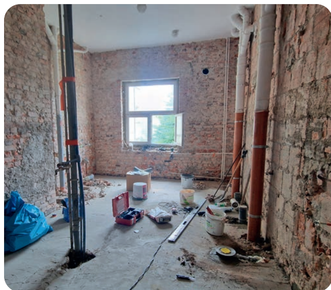
W Szkole Podstawowej nr 1 remontowane są m.in. łazienki
