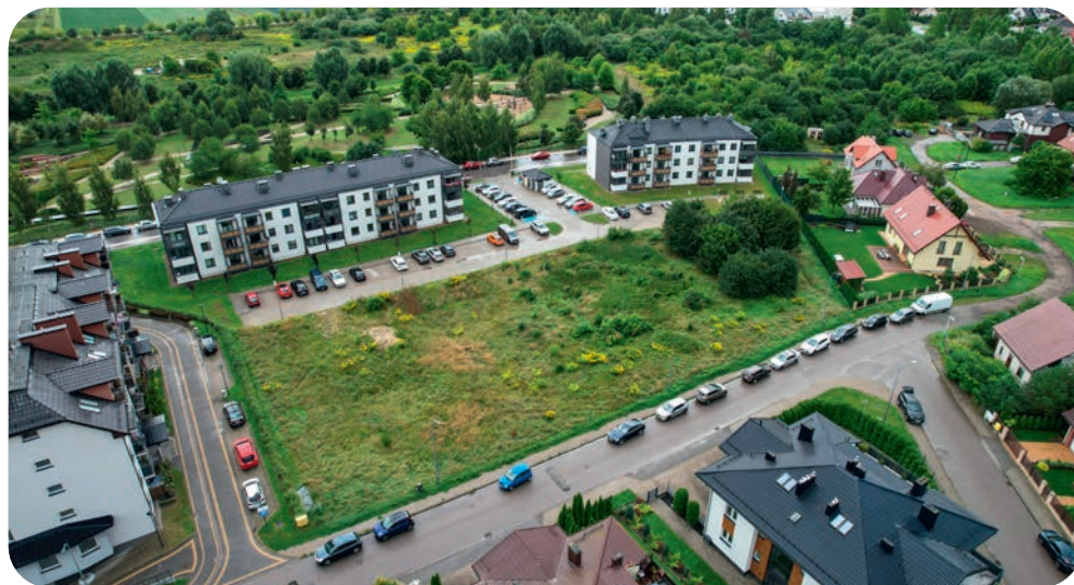
➤ W 2025 roku oddano do użytku budynek przy ul. Aliny 10
