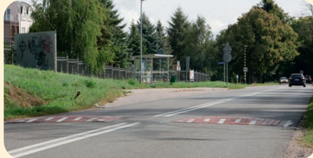
➔ Na wysokości osiedla Modre, powstało wyniesione przejście dla pieszych
